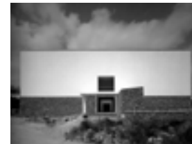
Edificio de Juzgados, Mahón, Menorca. 1992-96
