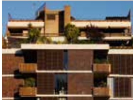
Apartamentos calle Bach 28, Barcelona. 1965
