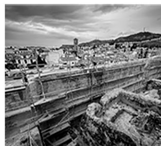
+ MURALLA ZIRI Construcción de paseo peatonal
