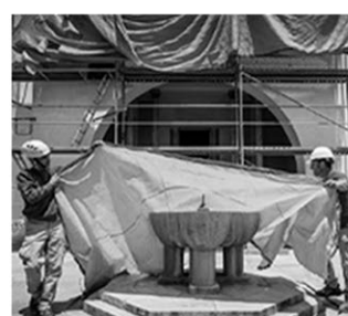
+ PLAZA MANUEL DE FALLA Construcción de paseo peatonal
