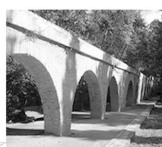
+ CARMEN MÁRTIRES Reparación del Acueducto
