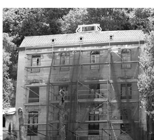
+ HOTEL BOSQUES DE ALH En estado ruinoso
