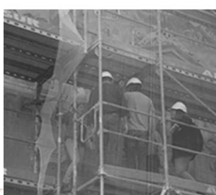
+ IGLESIA SAN CECILIO Rehabilitación fachadas y cubierta
