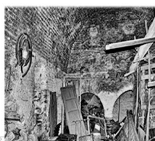
+ BAÑOS ALBAYCÍN Reconstrucción
