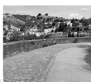
+ CAMINO AVELLANO Reparación del camino actual
