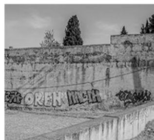
+ MURALLA ALBERZANA Construcción de paseo peatonal
