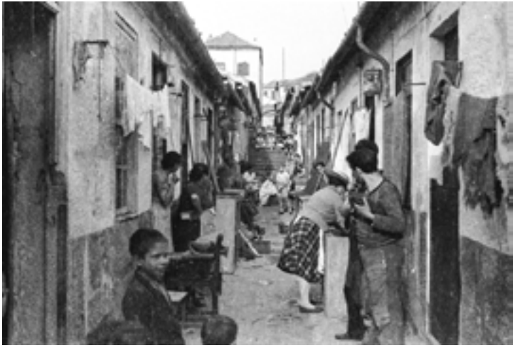
Interior de una ilha tipo corredor © Arquivo Municipal do Porto
