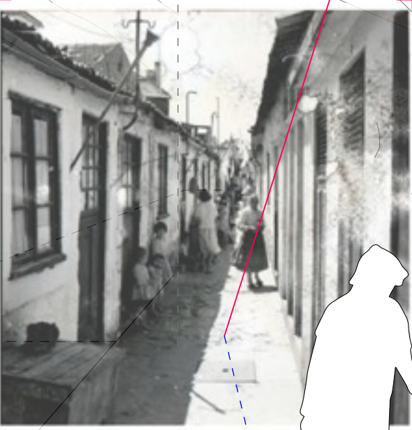
Interior de una ilha tipo corredor © Arquivo Municipal do Porto
