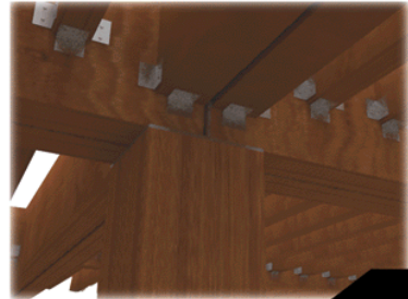
unión entre módulos de forjado y pilar
