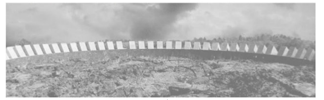
▲ CENTRO DEL ESPACIO ESCULTORICO. UNAM. Relación de la naturaleza con lo construido: intervenciones del hombre y sus límites
