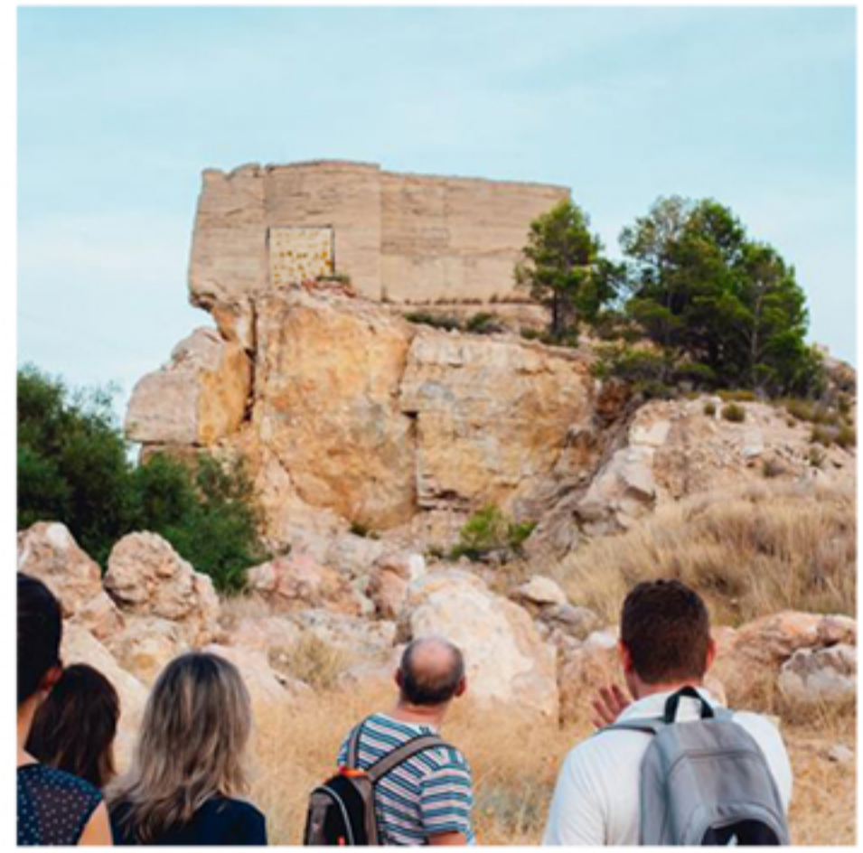
Vista de la antigua fortaleza antiáerea después de la intervención. Un refugio invisible.
