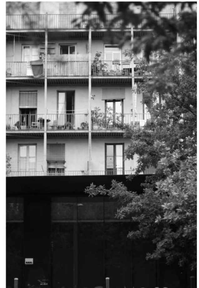
Interior biblioteca Sant Antoni Contraste fachadas Fuente: propia
