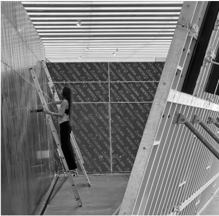
Montaje del pabellón CIMBRA, DHub
