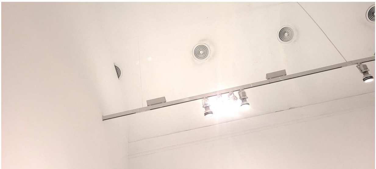
Bóveda en la tercera sala de “Maruja Mallo”
