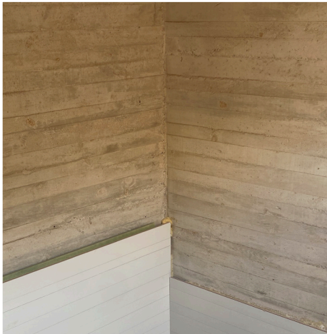
visita obra edificio Arquia
