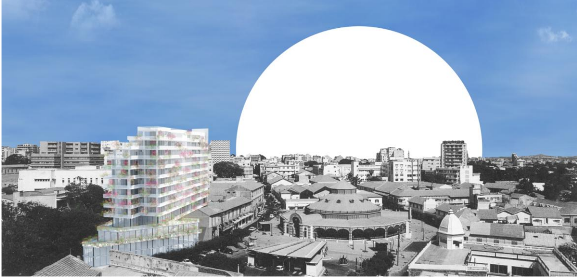
> Vista del hotel y la ciudad de Dakar
