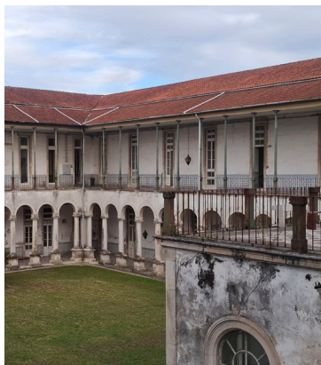
Interior del DARQ de Coímbra
