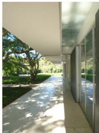
Imagen tomada desde el porche de la casa, con el gran lucernario lineal de la cubierta en su encuentro con la fachada sur.
