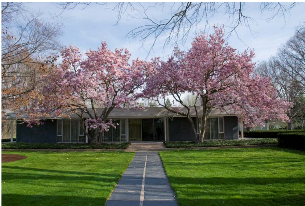
Fachada sur de la casa Miller. Camino en conexión con la piscina. Fuente IMA, Indianapolis Museum of Art
