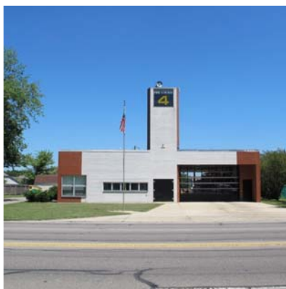
Fire Station nº4, de Robert Venturi en 1.967 Foto de Rickey Berkey
