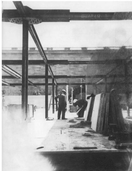
**8** Pilar compuesto por perfiles L, publicado en un manual alemán de construcción metálica de 1911, y en una segunda edición de 1924. Podemos ver el pilar de 4L del Pabellón de Barcelona y la casa Tugendhat.
