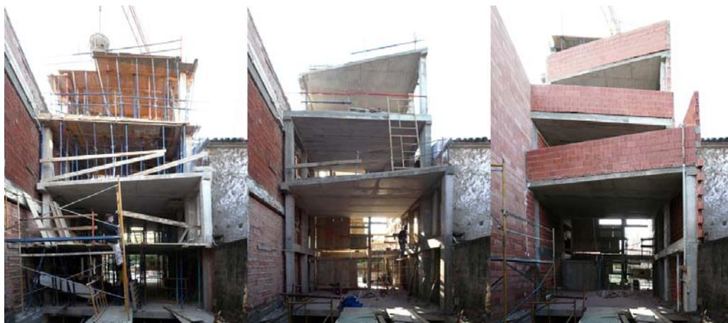
Los suelos consisten en recrecido de mortero de cemento con acabado fratasado fino, con sistema de calefacción por suelo radiante. Las terrazas se resuelven mediante un sistema de cubierta invertida transitable acabada en hormigón fratasado. La escalera es de chapa plegada de acero anclada a la estructura de hormigón. Los paños de fachada se ejecutarán en perfiles de U-glass, mientras los testeros o medianeras se recubrirán de una placa ondulada bituminosa.
