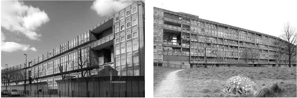
03.2.9 y 03.2.10_ Imágenes de las fachadas del bloque largo de siete plantas tomadas en el año 2013. A la Visión exterior e interior, a izquierda y derecha respectivamente (www.londonarchitectureblog.com).
