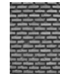
11 Ladrillo 1 Ladrillo macizo utilizado en los muros de la iglesia y en los muros laterales de los pabellones sin carga estructural y en todas las fachadas de planta baja
