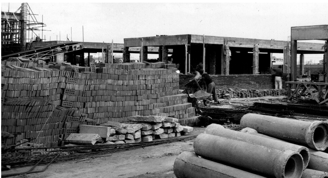
Figura 7. Imagen de visita de obra. A la izquierda acopio de ladrillos perforados. Al fondo a la derecha, obreros realizando el levantamiento del cerramiento principal. Navarro, Pablo.1960.
