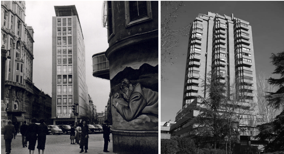
Figura 2. Vistas de los edificios de Galerías preciado y Torre del Retiro.
