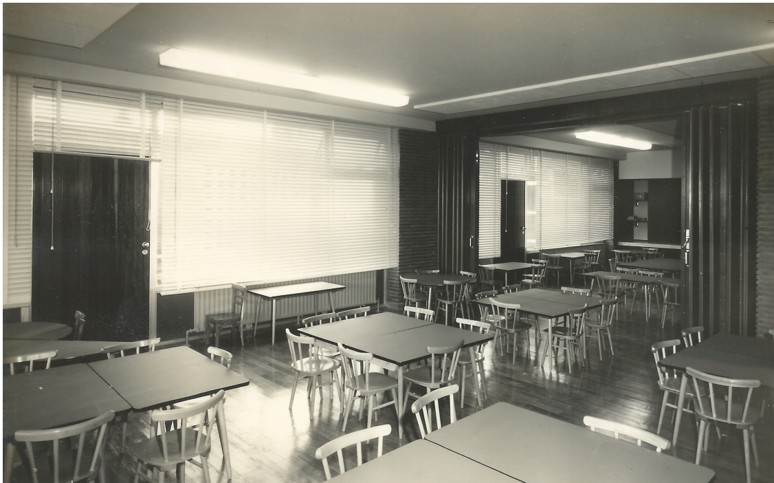
Figura 10. Vista interior de las aulas compartimentadas por la Harmonikatür. Navarro, Pablo.1960.
