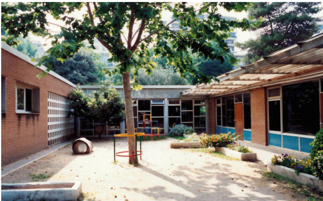
Figura 9. Imagen previa a la demolición del Kindergarten. Vista de uno de los patios. Lladó, Ana. 1995.
