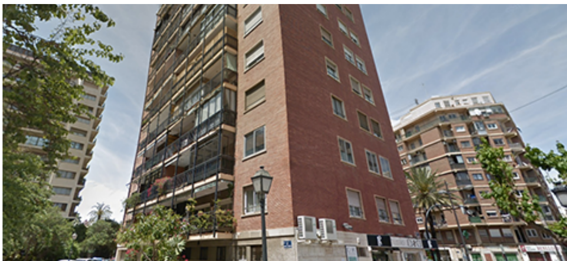
Figura 14. Vista actual del bloque de edificios proyectados por el arquitecto junto con Julio Trullenque en la Calle Plaza Musico Albéniz 2-3.
