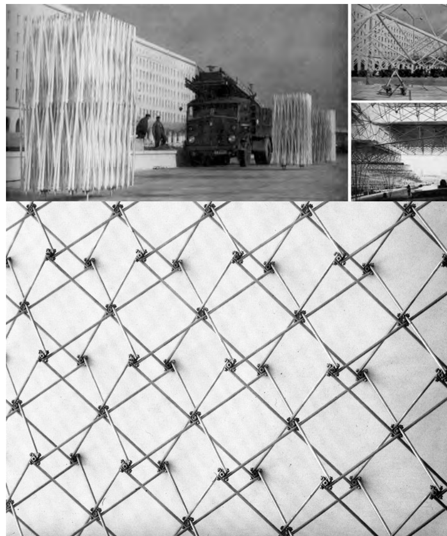
Fig.9. Proceso de desplegado y patrón estructural del sistema del haz de barras en el pabellón transportable de conmemoración de XXV años de paz, Madrid, Barcelona y San Sebastián. Archivo Pérez Piñero.
