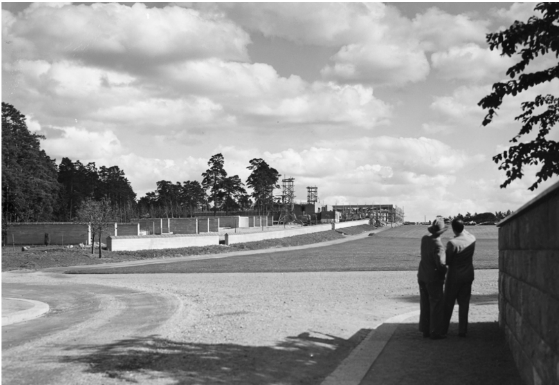
El Crematorio del Cementerio del Bosque durante su construcción en 1938
