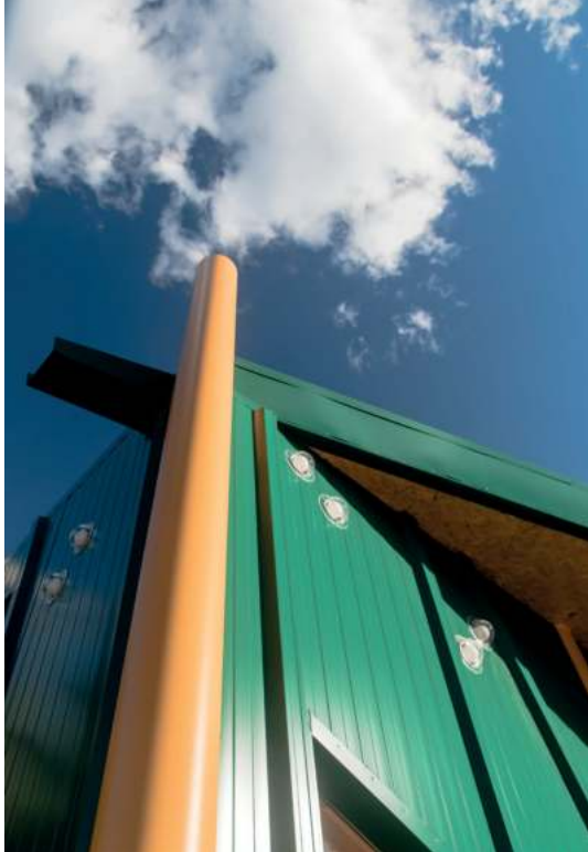
< Detall de les parets metàl·liques exteriors. Fotografia: Carles Berché
