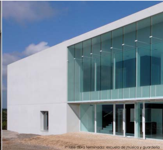
1ª fase obra terminada: escuela de música y guardería
