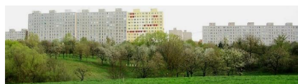
Figura 12. Edificios residenciales en Praga.
