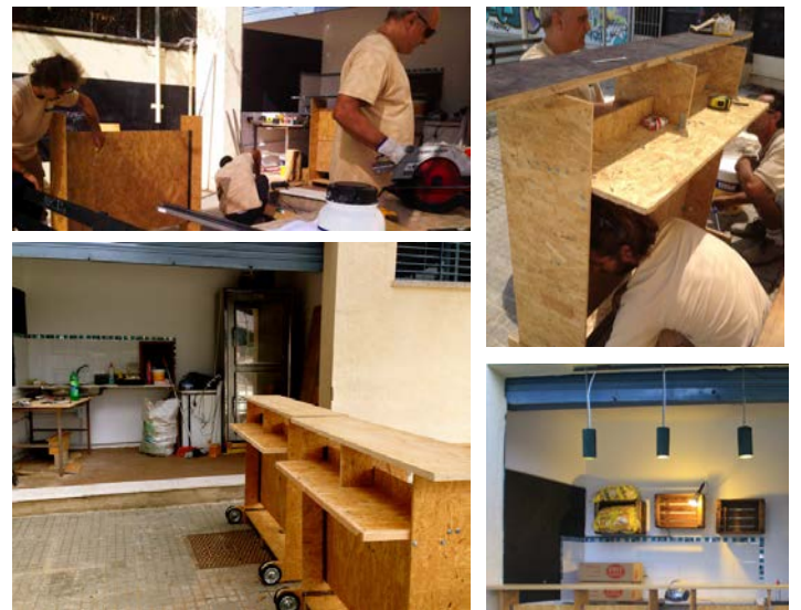
Nueva configuración del bar: construcción de una barra mas ligera y mobil, tratamiento de una pared con pintura de pizarra y nuevas estanterías.
