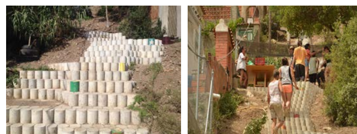
Actualmente se ha finalizado la mitad de la obra de escalera.
