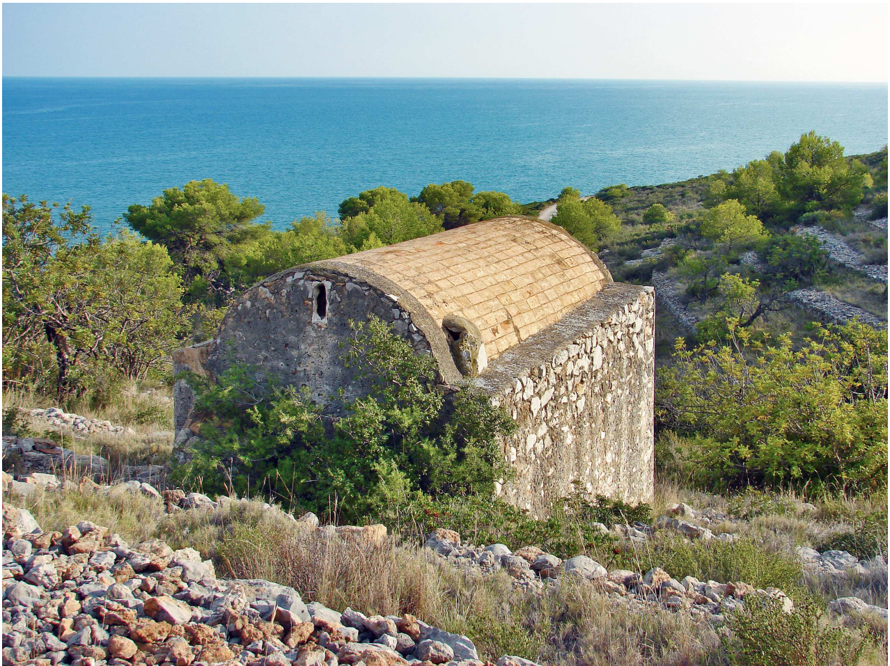
Casetas de volta, de bóveda tabicada, en la sierra de Irta, en término de Peñíscola, (Baix Maestrat, Castellón)
