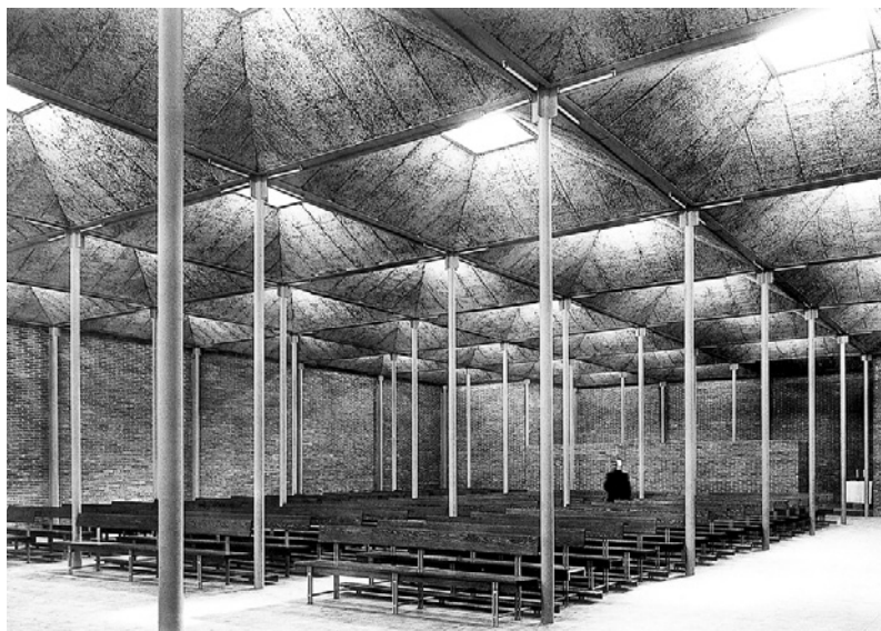
Concurso de la Iglesia de San Esteban en Cuenca, 1960. Maqueta de la cubierta modular con cúpulas para introducir luz natural en su interior, croquis del exterior y maqueta del interior.
