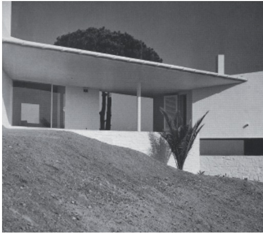
fig.1.Porche de la casa Ugalde
