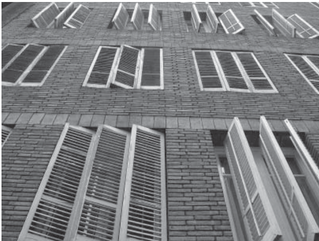
fig 25 Fachada de las viviendas de la Calle Encarnación de Barcelona
