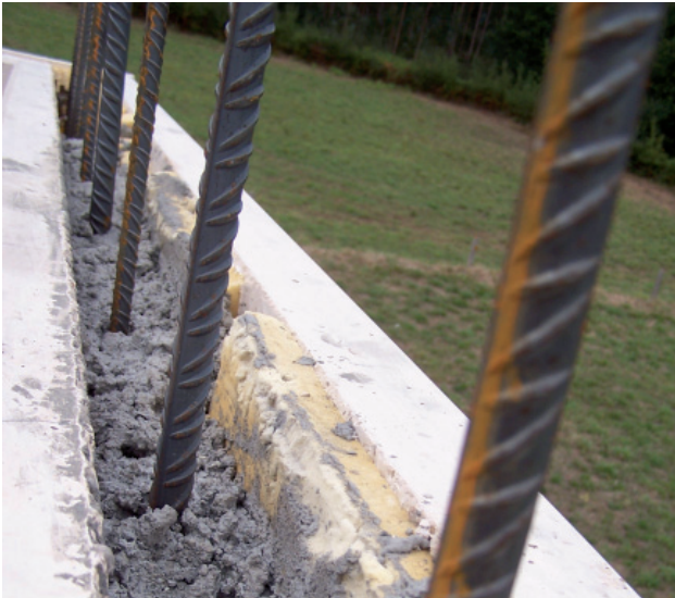
Figura 22. Detalle de los muros hormigonados y las esperas para conectar con el siguiente anillo.
