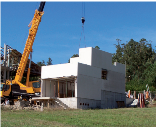
Figura 24. Colocación del segundo anillo de la estructura.
