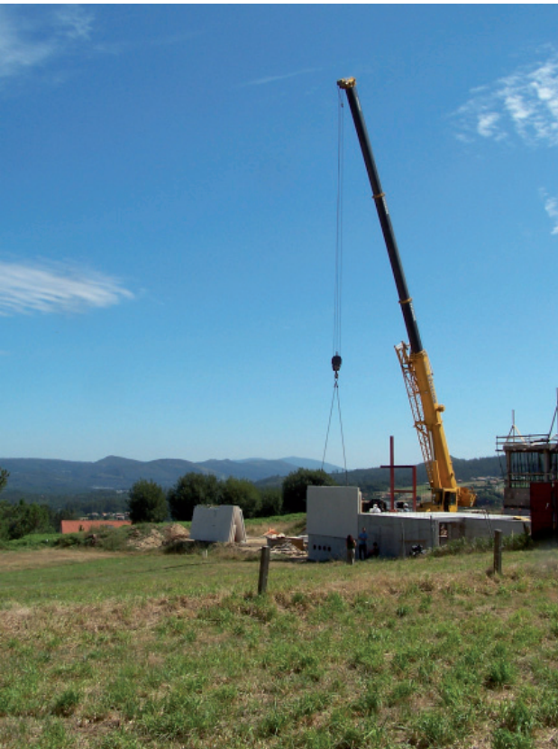
Figura 18. Colocación de los primeros paneles P1 y P2.
