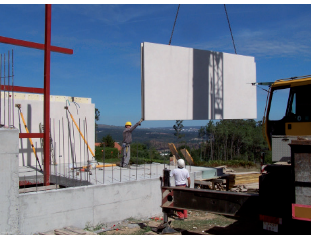
Figura 19. Panel 2 apuntalado desde el interior.
