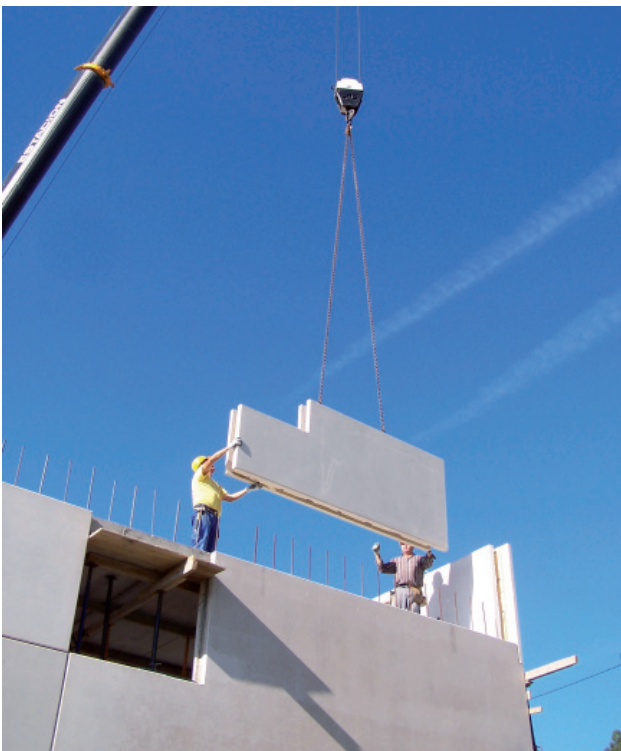
Figura 23. Colocación de paneles de geometría irregular.
