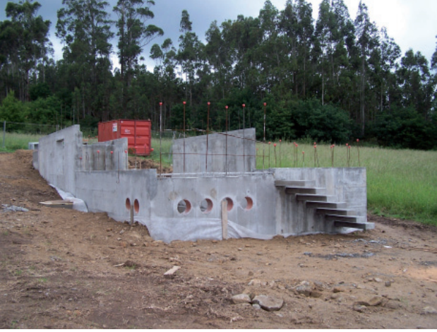
Figura 17. Arranque de la estructura in situ.
