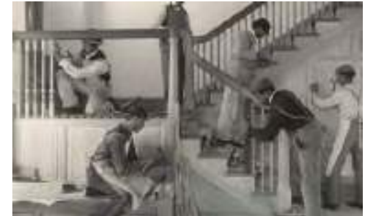
Construcción de una escalera, Juntos - Richard Sennett (2012)
