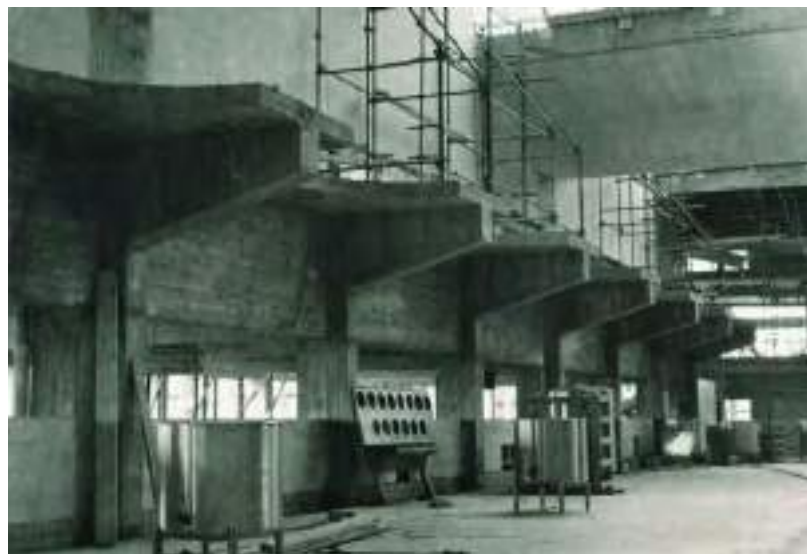
FÁBRICA CLESA EN CONSTRUCCIÓN 1958-1960 imagen de archivo fundación A. Sota
