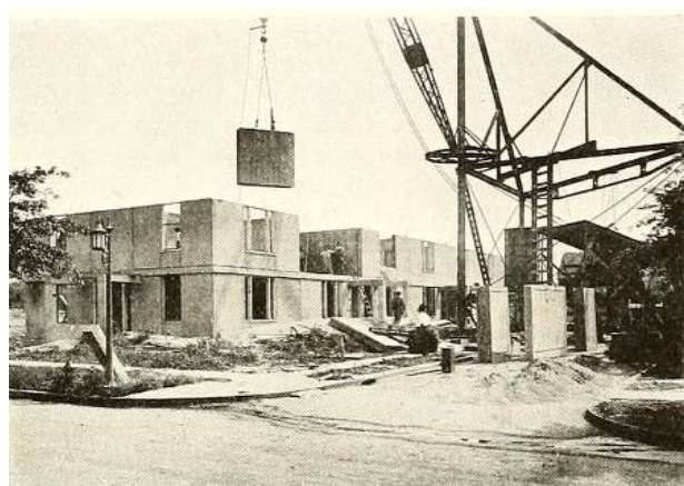
Método de construcción de paneles de hormigón con diseño de grúa móvil para su ensamblaje en las viviendas de Forest Hills Gardens, de Grosvenor Attembury. Regional survey of New York and its environs, vol. VI, Buildings: their uses and the spaces about then, 1931.ork.
