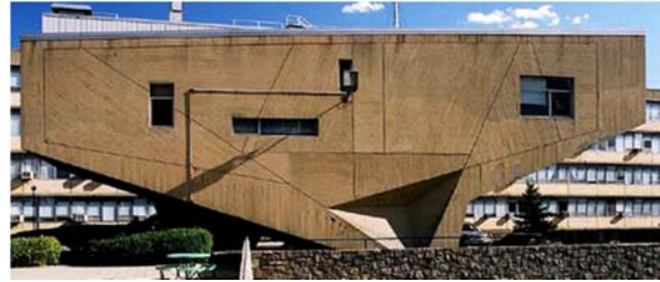
Fig. 16: Marcel Breuer. Líneas de encofrado del hormigón en el Begrish Hall. New York University, University Heights, New York, 1959-61.
