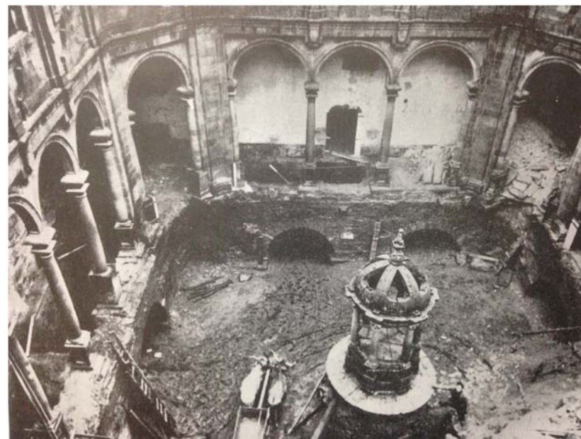
Obras de intervención en uno de los patios. Hospital Real de Santiago de Compostela. V.V.A.A. (1958): Veinte años de restauración monumental de España. Catálogo de la Exposición. Madrid 1958. Madrid, Ministerio de Fomento, 2001 (Reimpresión), LÁM. L.
