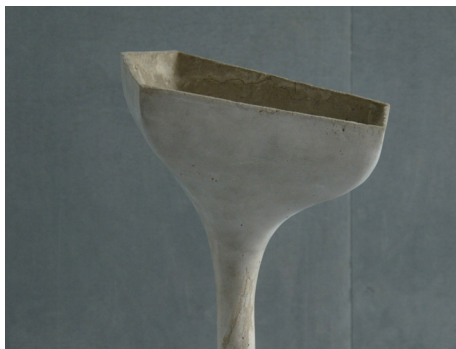
Little Island, Pier 55. Heatherwick Studio. Maqueta de una de las estructuras "tulipán" de hormigón prefabricado que sirven de base al nuevo paisaje.
