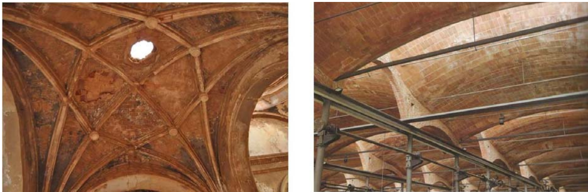
Figura 2: A la izquierda, bóveda tabicada “tradicional”: la iglesia de San Martín de Belchite, del siglo XVI. (imagen cedida por Paula Fuentes). A la derecha, nueva construcción tabicada: el vapor Aymerich, en Tarrasa, del Luis Muncunill, construido en 1908 (imagen de la autora).
