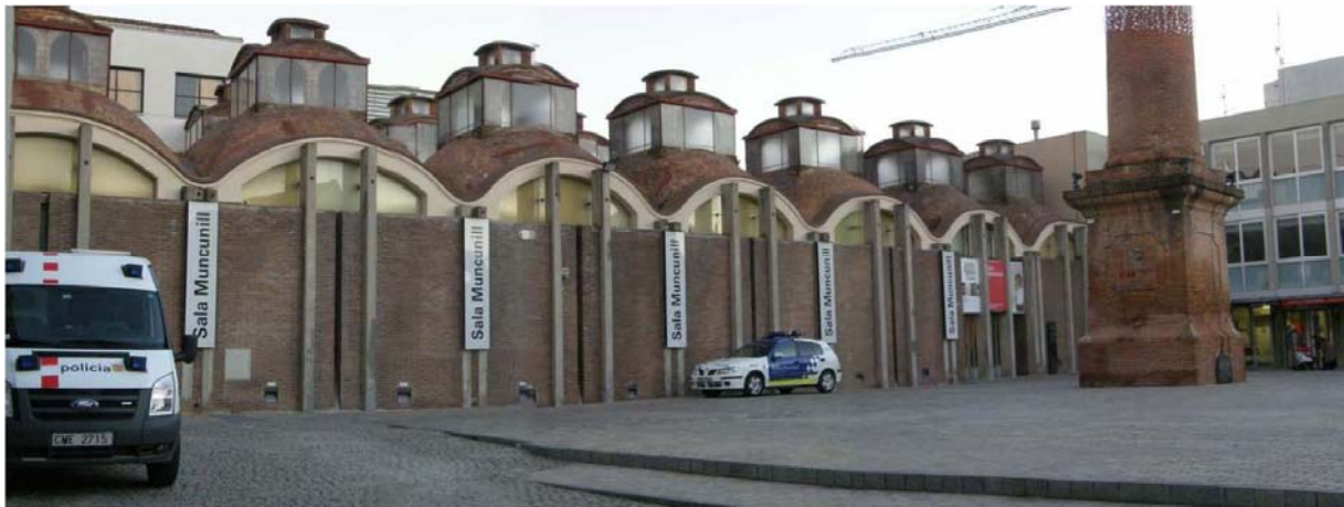
Figura 13: El Vapor Amat, otro edificio de Luis Muncunill en Tarrasa, de 1914. Aquí el sistema constructivo son bóvedas vaídas apoyadas sobre un entramado de vigas y pilares metálicos, con grandes lucernarios en la parte superior de cada una. Al exterior quedan vistas. Este edificio es ahora el «Espacio Muncunill», una sala de exposiciones (imagen de la autora en 2013)
