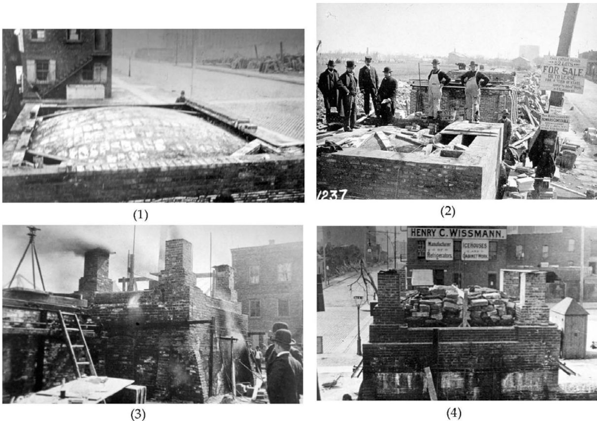
Figura 20: Desarrollo de un ensayo de carga y fuego realizado por Rafael Guastavino en Nueva York en 1897: (1) y (2) se construye una bóveda tabicada similar a las que construye habitualmente, pero con cuatro huecos-chimenea en las esquinas, sobre muros también de ladrillo (3) se coloca sobre la bóveda una carga habitual (6,30 kN/m 2 ), se prende en su interior un fuego, que dura 4 horas. Se miden temperaturas durante el proceso, alcanzándose máximos de 1300° C.
