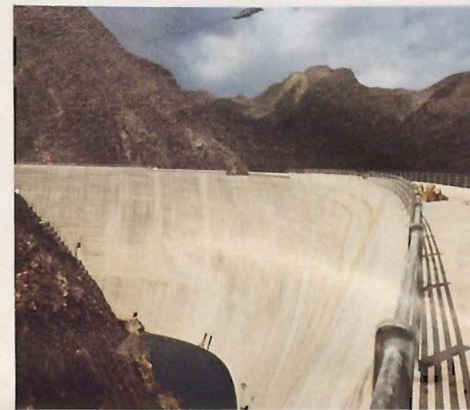
presa de Llauset
