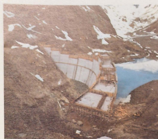
presa de Llauset. En construcción (30.5.1983)
