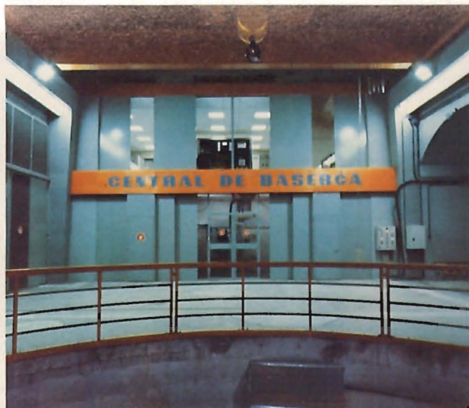
central de Baserca. Nave superior
