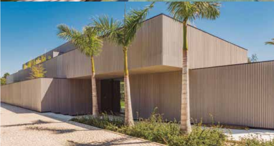
Fotografías: Jamena Construcciones, S. L.
