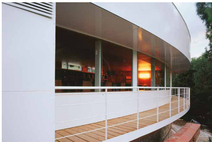
Figura 2. Vista exterior del edificio de ampliación. Estudio Cano Lasso, 2006.
