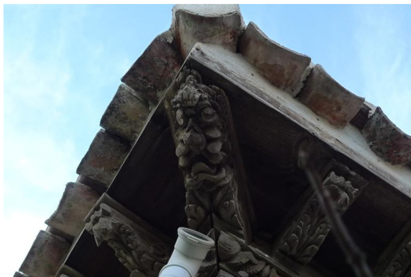
Vista frontal, inferior y lateral del can de esquina grotesco de Loeches.
