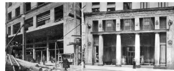
Fig 9 Estructura en construcción sin columnas y fachada terminada con las columnas colocadas una vez terminada la estructura.
