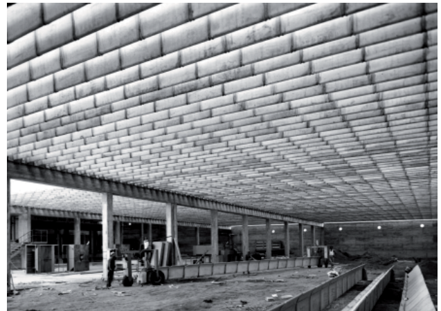
HUECOSA es el verdadero intento de industrializar los huesos . Diferentes imágenes del proceso de fabricación y montaje de vigas-hueso en Vic, Barcelona. En la imagen lateral Miguel Fisac comprobando los procesos de fabricación de las dovelas de HUECOSA. Archivo Arumí.
