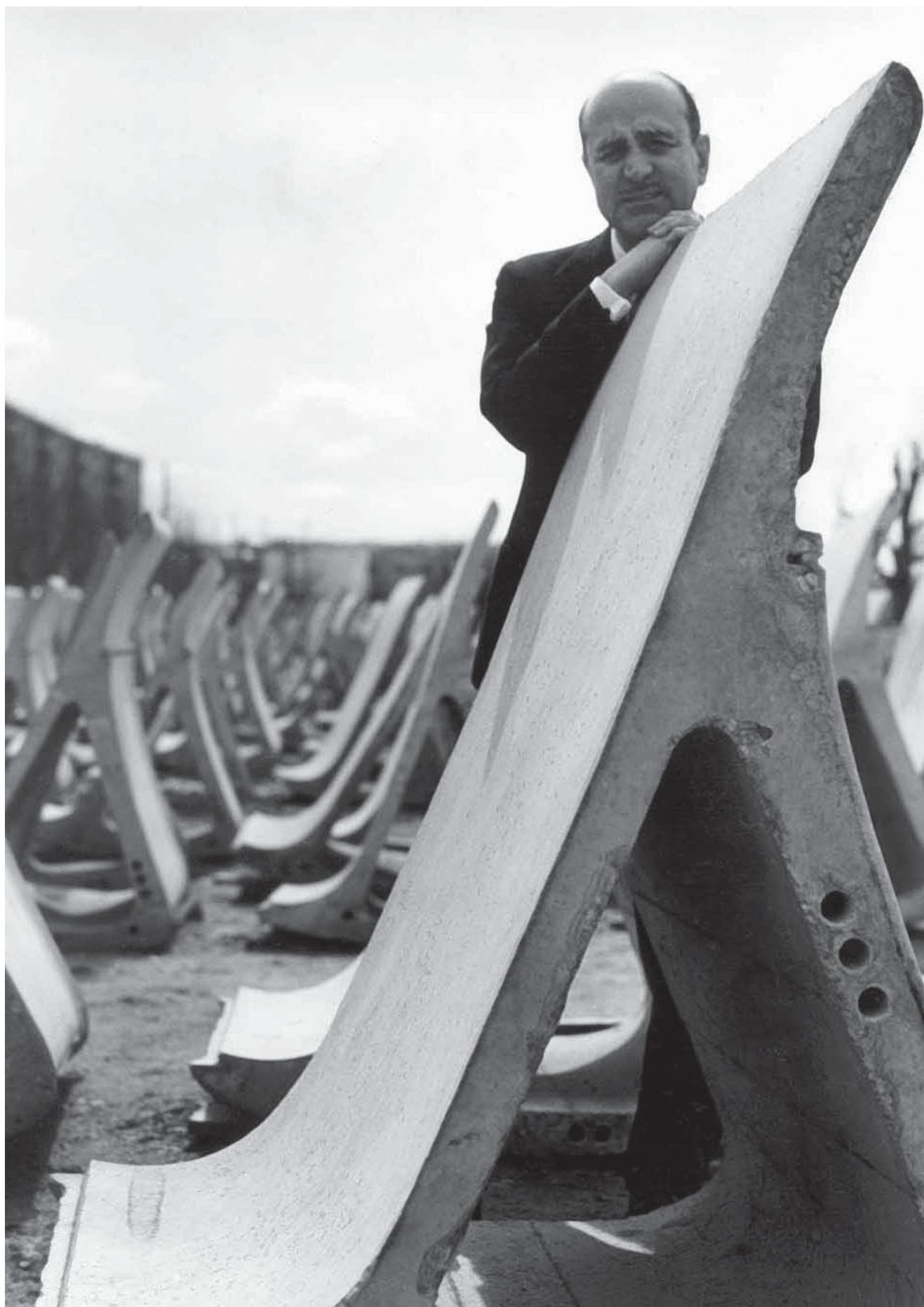
Miguel Fisac con las piezas prefabricadas del Centro de Estudios Hidrográficos. 1961. Archivo Fundación Miguel Fisac. Ciudad Real.
