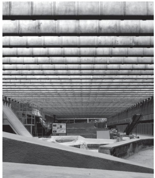
Interior de la Nave de Modelos del Centro de Estudios Hidrográficos, Madrid. Foto Alex del Río. (2006). Tras la rehabilitación de ALVISA, las vigas fueron sustituidas por las réplicas actuales.
