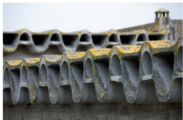
Pieza Valladolid (PEIRO) en el centro parroquial de Moratalaz (1965) Foto Fundación Miguel Fisac y en el Colegio de Santa M a del Mar en Coruña. Foto Alex del Río. (2006).
