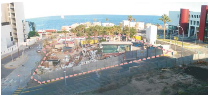
Panorámicas del solar desde el edificio de aparcamientos
