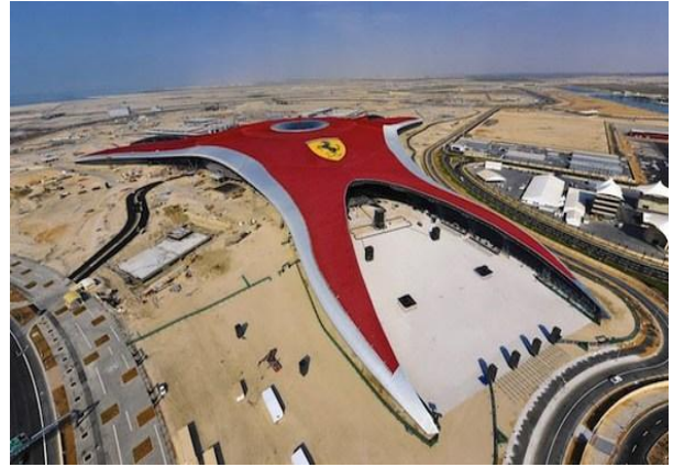
El parque temático "Ferrari World" en Abu Dhabi, es un buen ejemplo de un conjunto de pistas y circuitos descontextualizadas del entorno. Se trata de una muestra de espacios viarios convertidos en lo que algunos llaman "urbanismo de llavero". Fuente: http://www.cochesmas.com con acceso 23/11/2012
