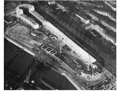
Rotterdam. Kop van Zuid, bloque de viviendas Peperklip, 1978 (Carel Weeber).
