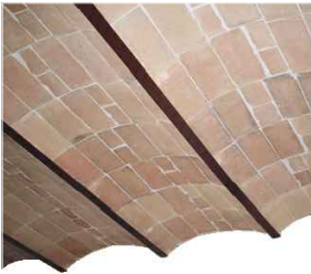
forjado tradicional de bovedilla catalana
