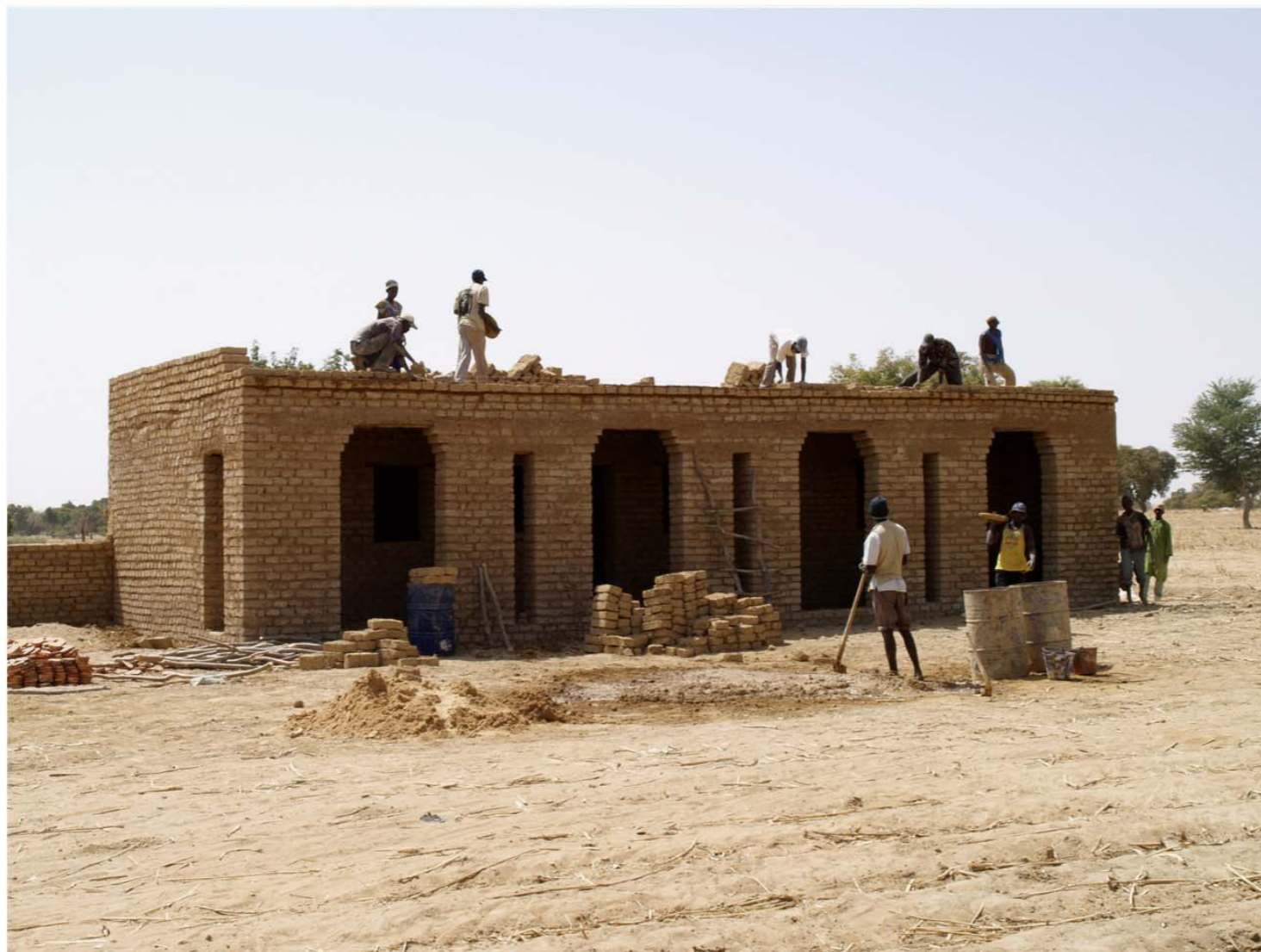
::: voyage en solidaire ::: principios de febrero '08, construcción del bloque principal, sirabougou
