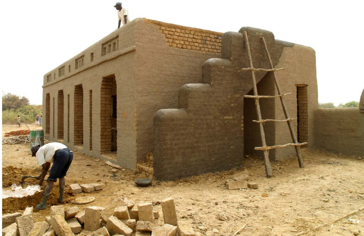
::: voyage en solidaire ::: finales febrero '08, construccion del tiro de escalera, sirabougou
