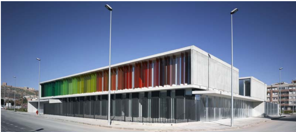
Centro de Salud Mental, Unidad de Rehabilitación y Hospital de día Psiquiátrico de Lorca.
