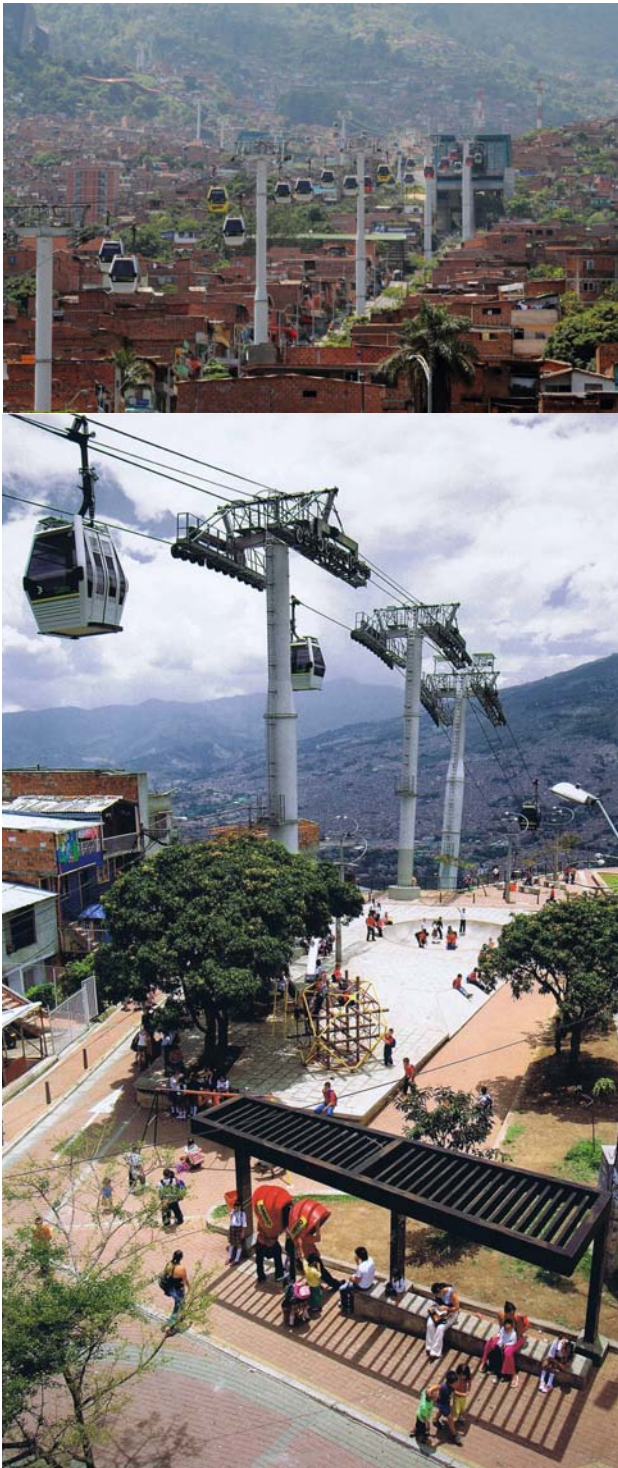
Fig. 121 y 122. Metrocable de Medellín. Foto aérea y zona de descanso.
