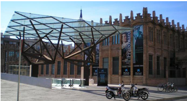
Fig. 142. Acceso a Caixa Forum en Barcelona por Arata Isozaki.
