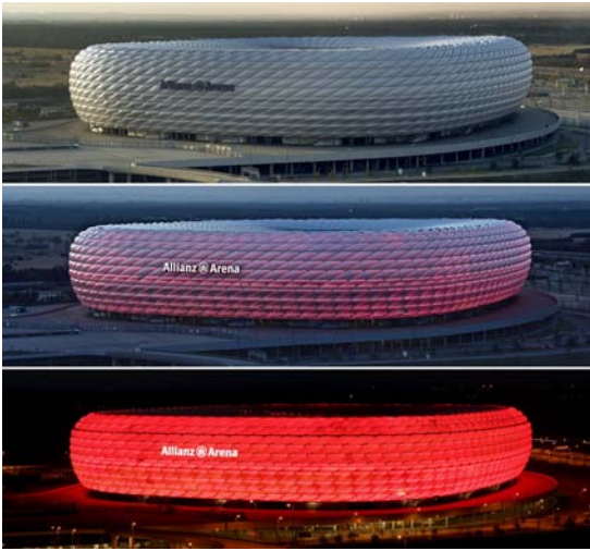
Fig. 50. Vista exterior del Allianz arena. Munich (Alemania). Herzog & de Meuron.
