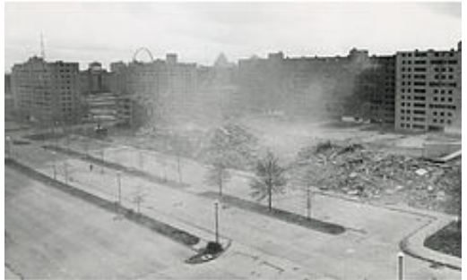
Fig. 133. Secuencia de imágenes de la segunda demolición retransmitida por televisión.
