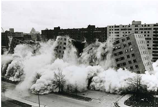
Fig. 134. Pruitt Igoe. primera fase de demolición.
