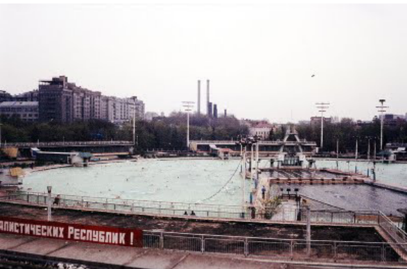
Fig. 73. Piscina Moskva sobre la excavación para la cimentación del Palacio de los Soviets. Moscú (URSS), 1980. La piscina se destruyó para reconstruir la Catedral de Cristo Salvador entre 1995 y 2000.
