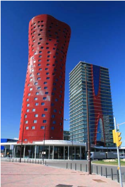
Fig. 74. Torres de Toyo Ito para la fira de l’Hospitalet. Barcelona.
