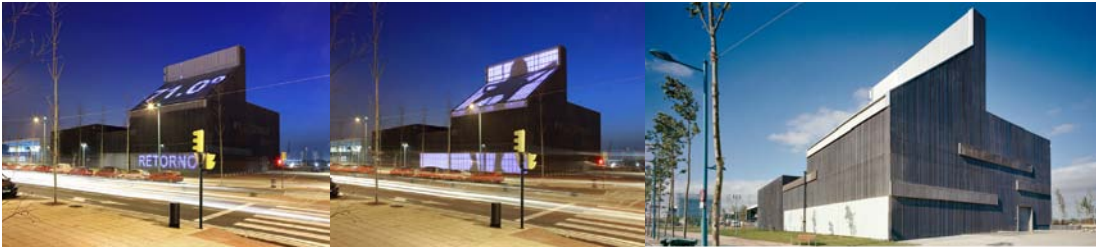
Fig. 46, 47 y 48. Central de energía de DHC en la periferia de Zaragoza. Iñaki Alday Jover.
