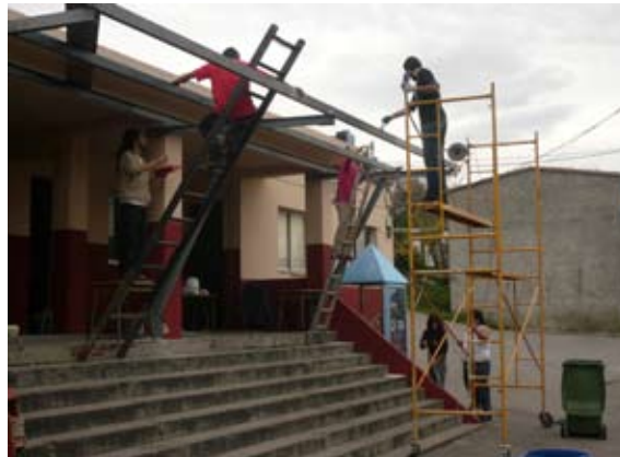
Fotografías do proceso de montaxe da pérgola de cubrición do soportal do Centro Social.
