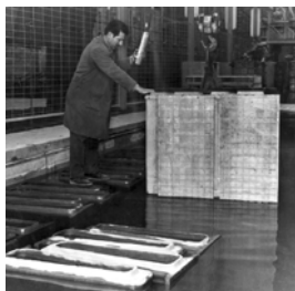
HUECOSA. Supone el intento de control absoluto del proceso, hormigones de altas calidades, moldes manejables de aluminio semi-desmontables y procesos de curado al vapor e inmersión en piscinas de las piezas. La planta de prefabricación de Juliá Arumi supone un ejemplo modélico del proceso de prefabricación, (imágenes del proceso de fabricación).
